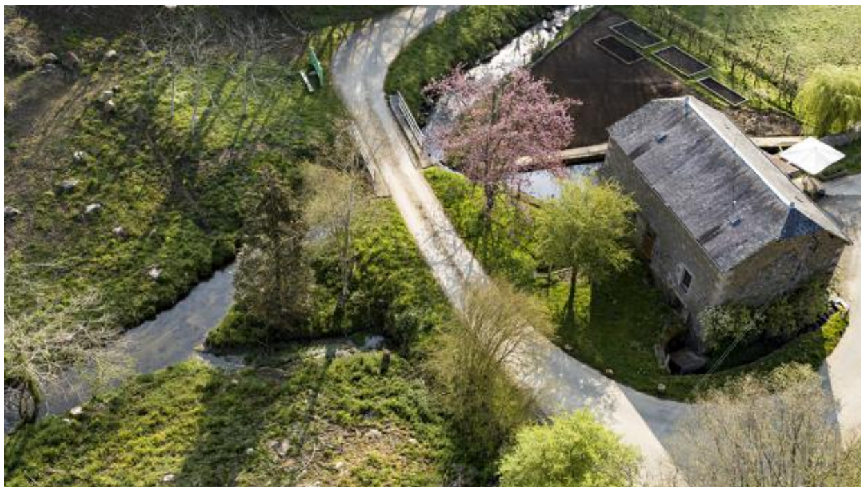
Vue aérienne du moulin de la Monnerie.
