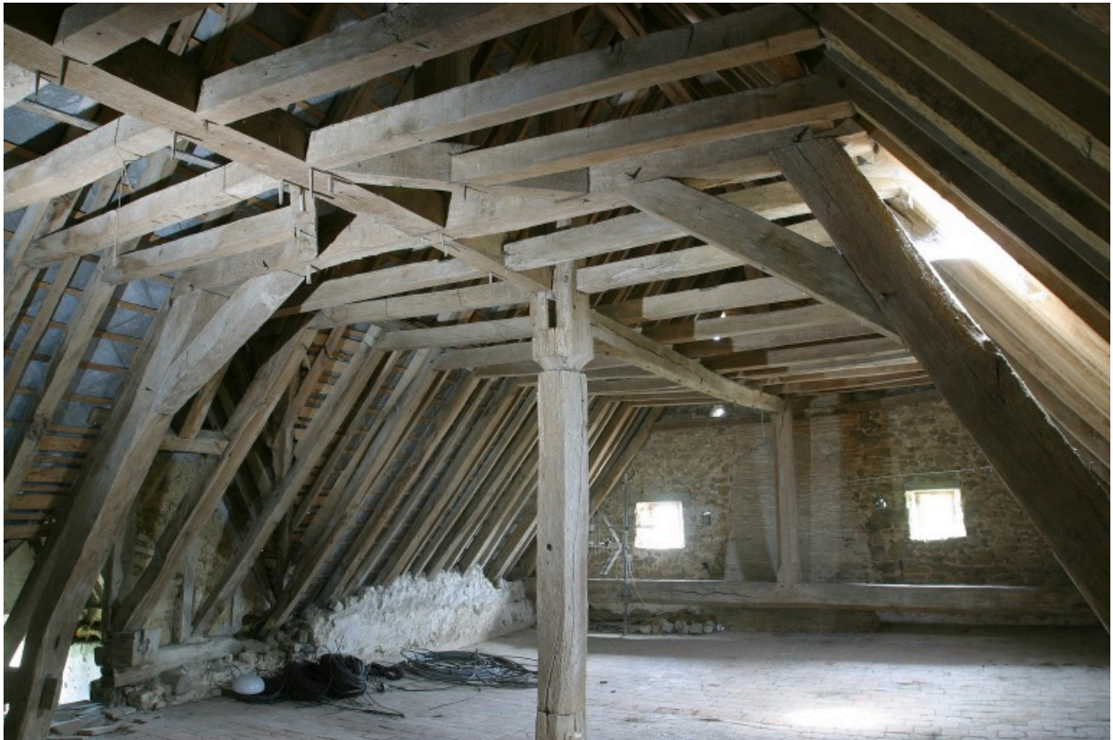
Comble. Vue d'ensemble de la charpente depuis le sud-ouest.
