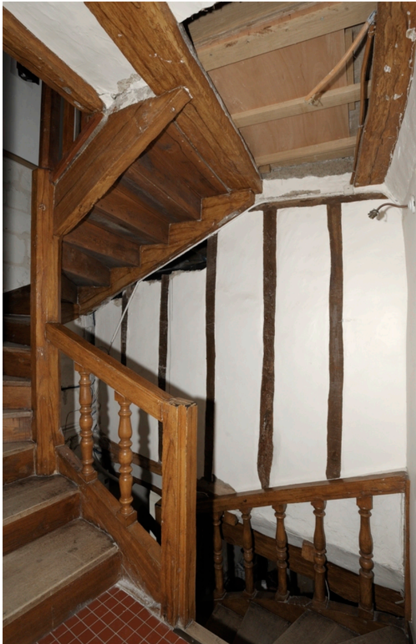
Escalier intérieur tournant en charpente, du XVIIe ou du XVIIIe siècle.
