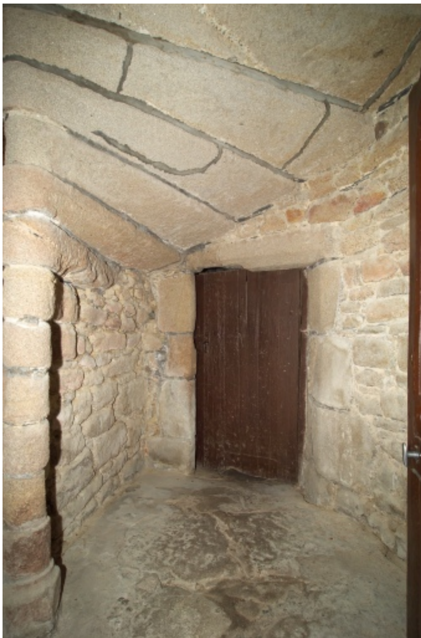
Rez-de-chaussée de la cage d'escalier.
