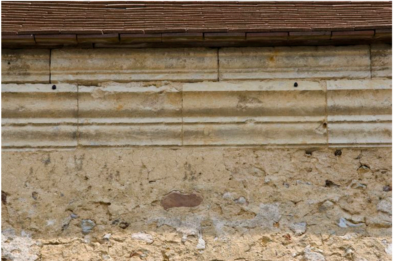
Détail de la corniche du mur ouest du bas-côté nord
