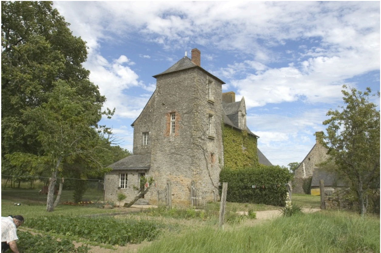
Le pignon ouest et le pavillon.
