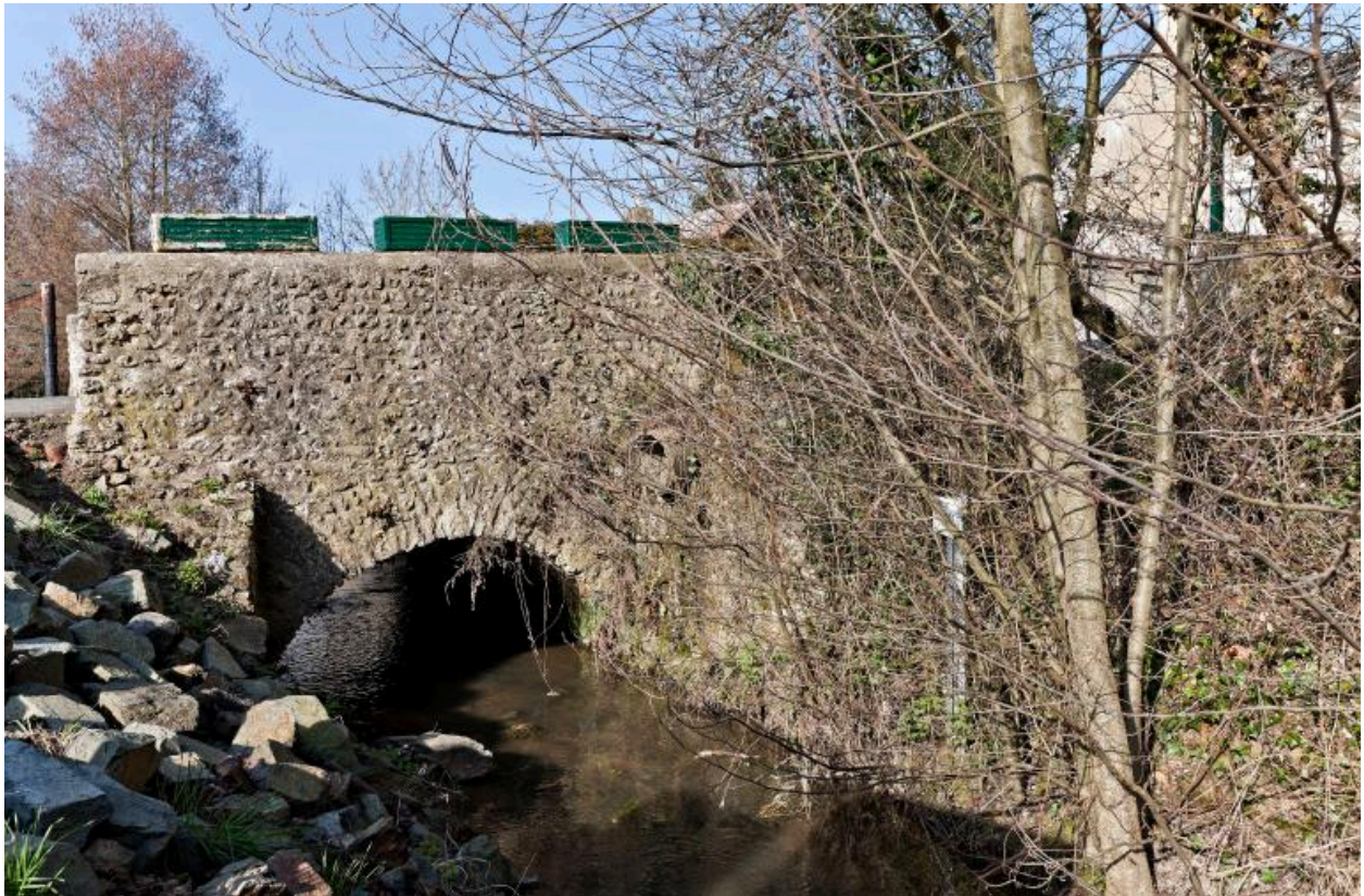
Pont sur l'Ire à la sortie du bourg (route des Blancs).
