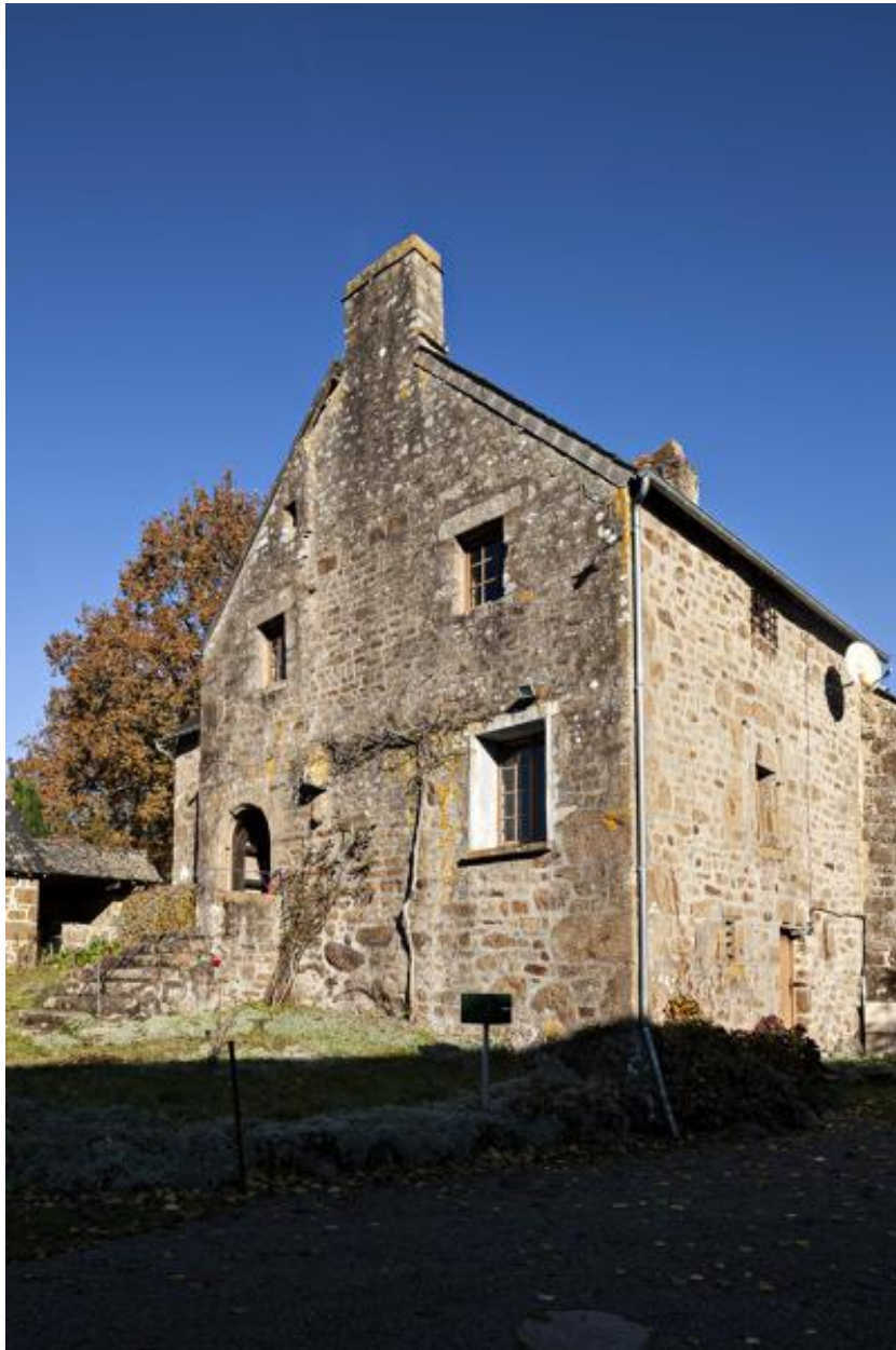
Logis sud, mur-pignon.
