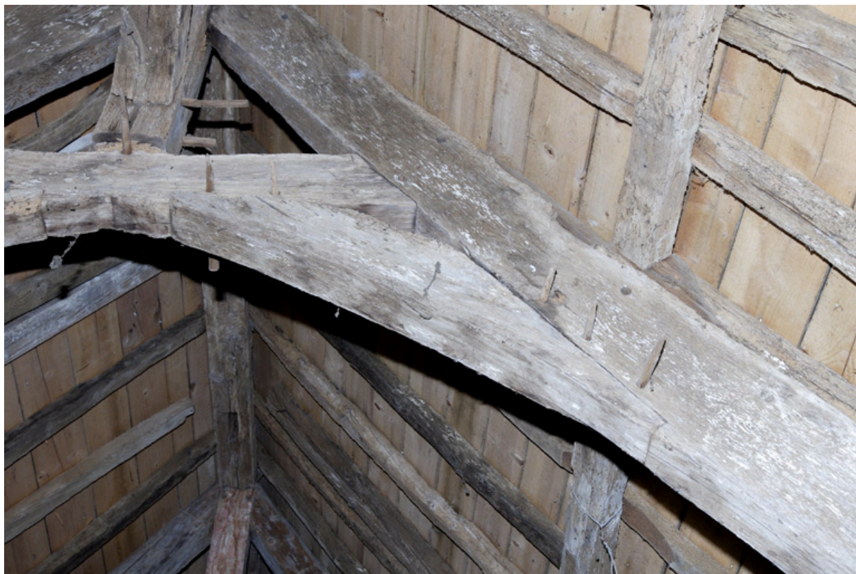
Logis. Charpente. Détail d'un lien.
