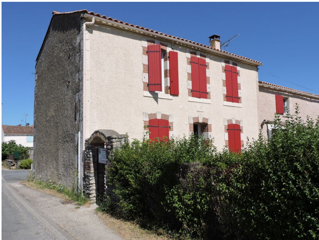
Le logis vu depuis le sud-est.
