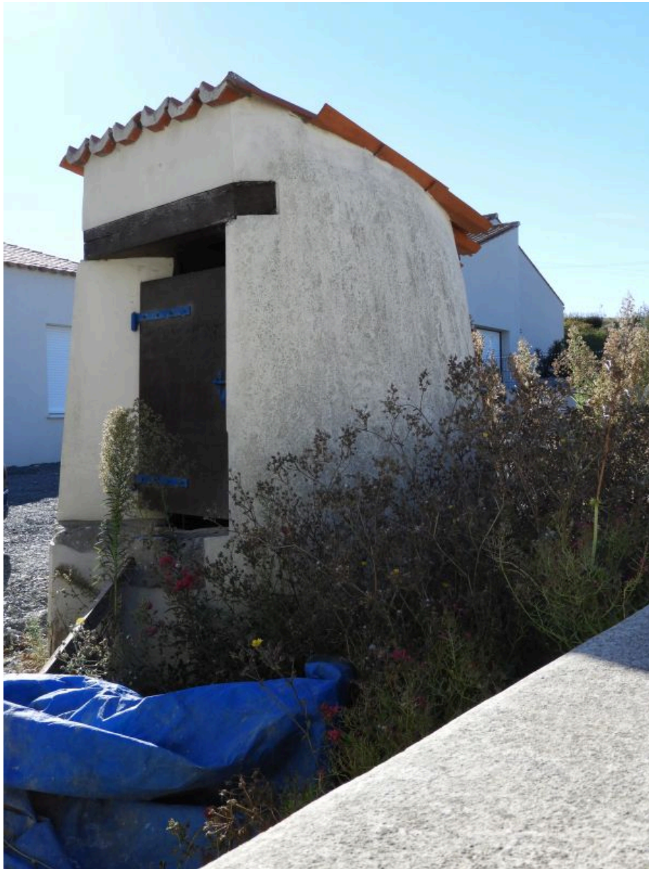
Le puits coiffé au sud de la grange-étable, vu depuis le nord-ouest.
