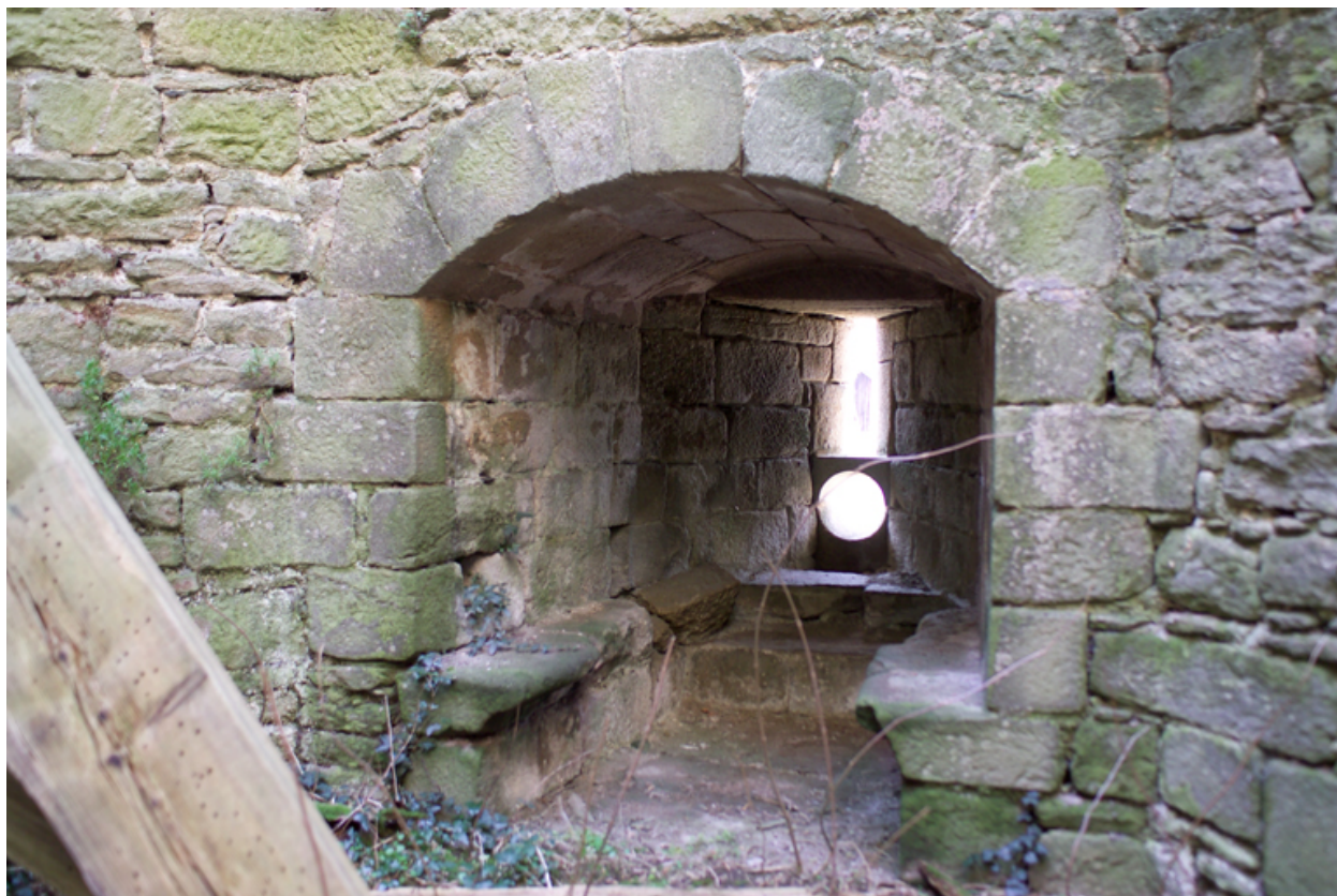
Ouverture de tir au rez-de-chaussée.
