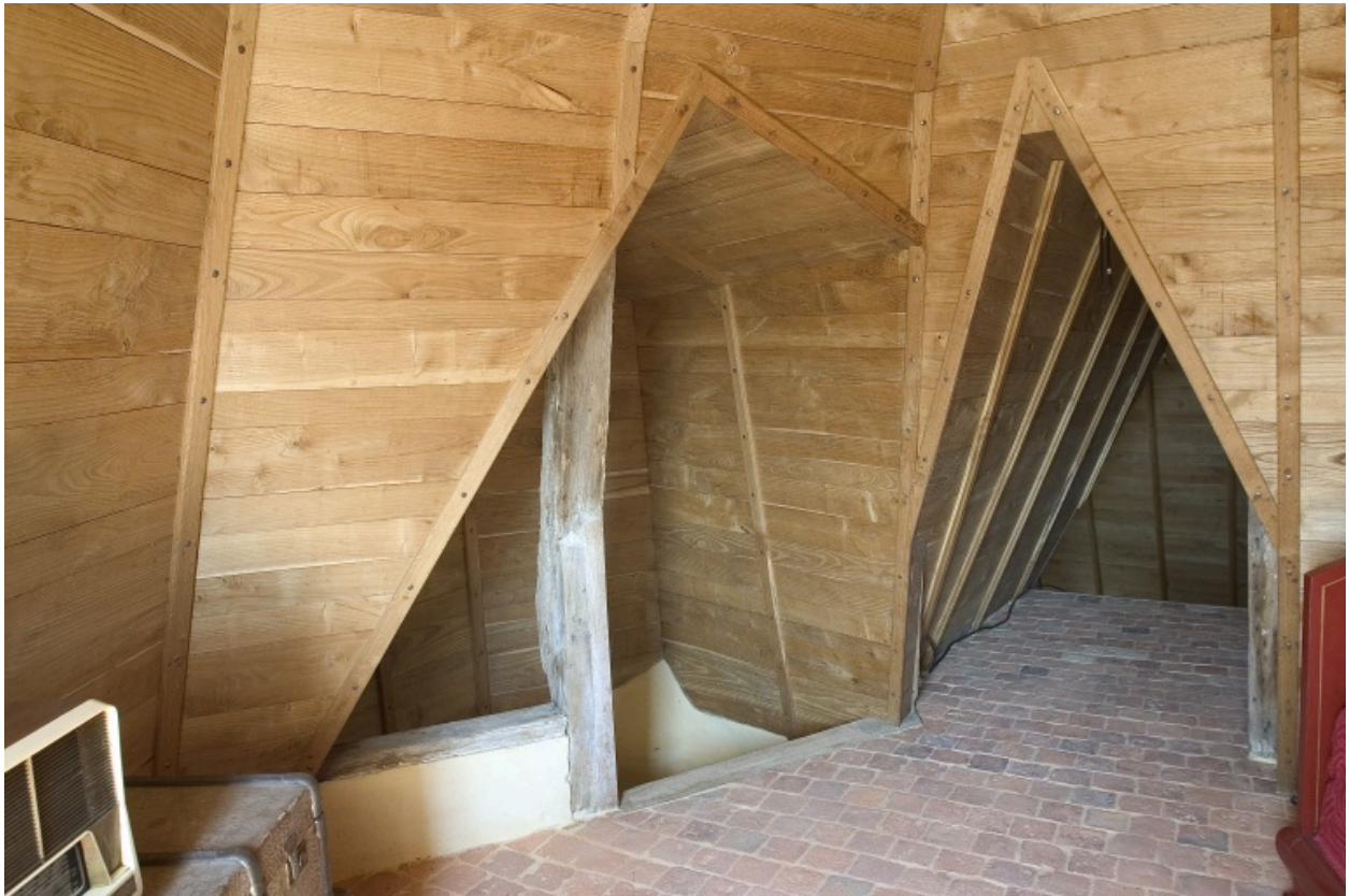
Intérieur du logis, comble : la pièce située dans la tour.
