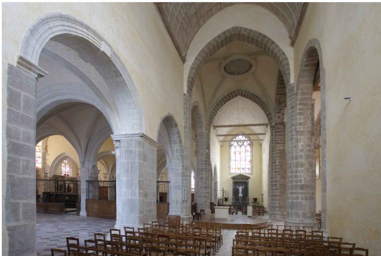
Transept, bras droit restauré : vue d'ensemble depuis le bras gauche.
