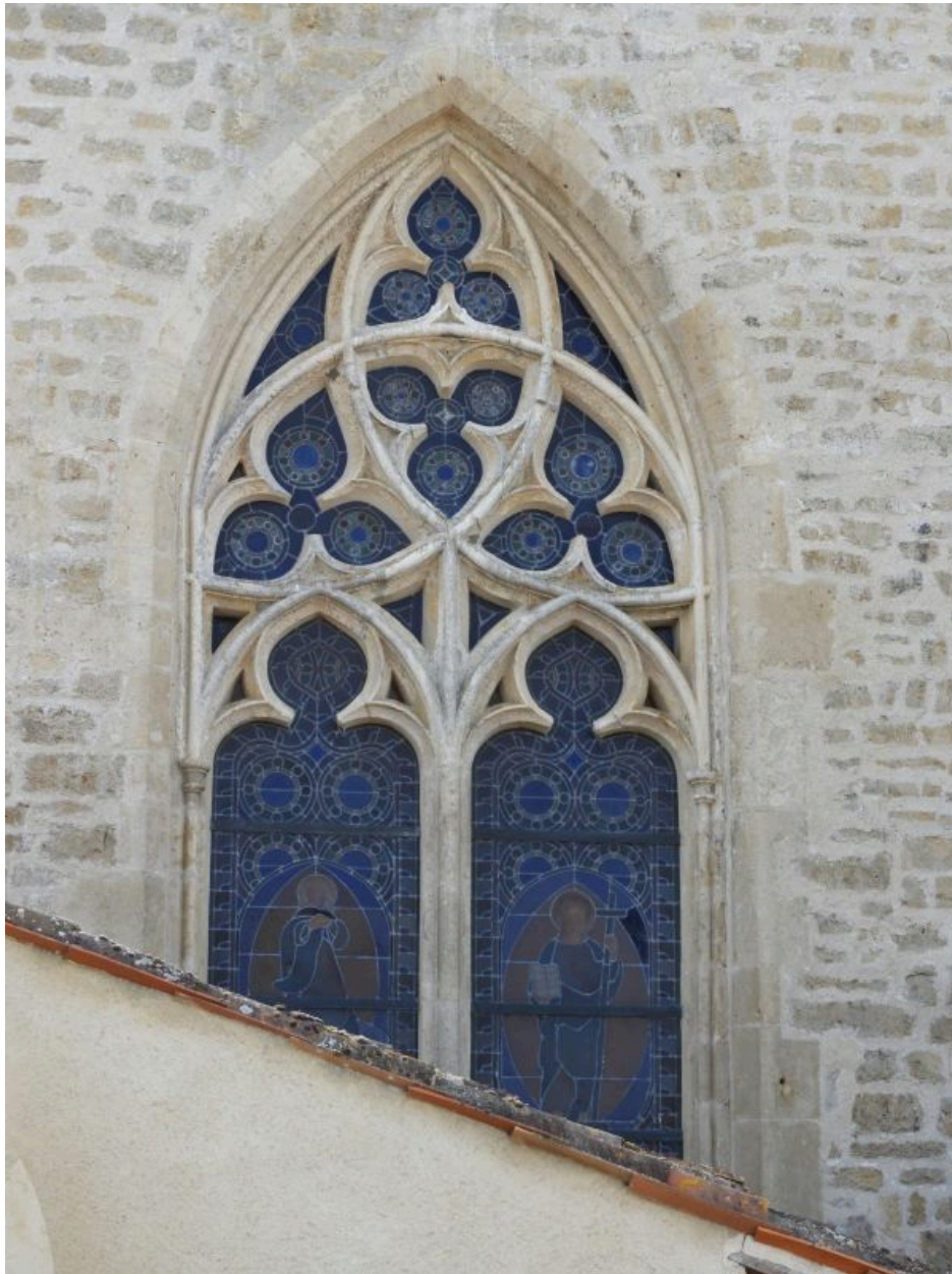
La baie d'axe du chevet, à réseau.
