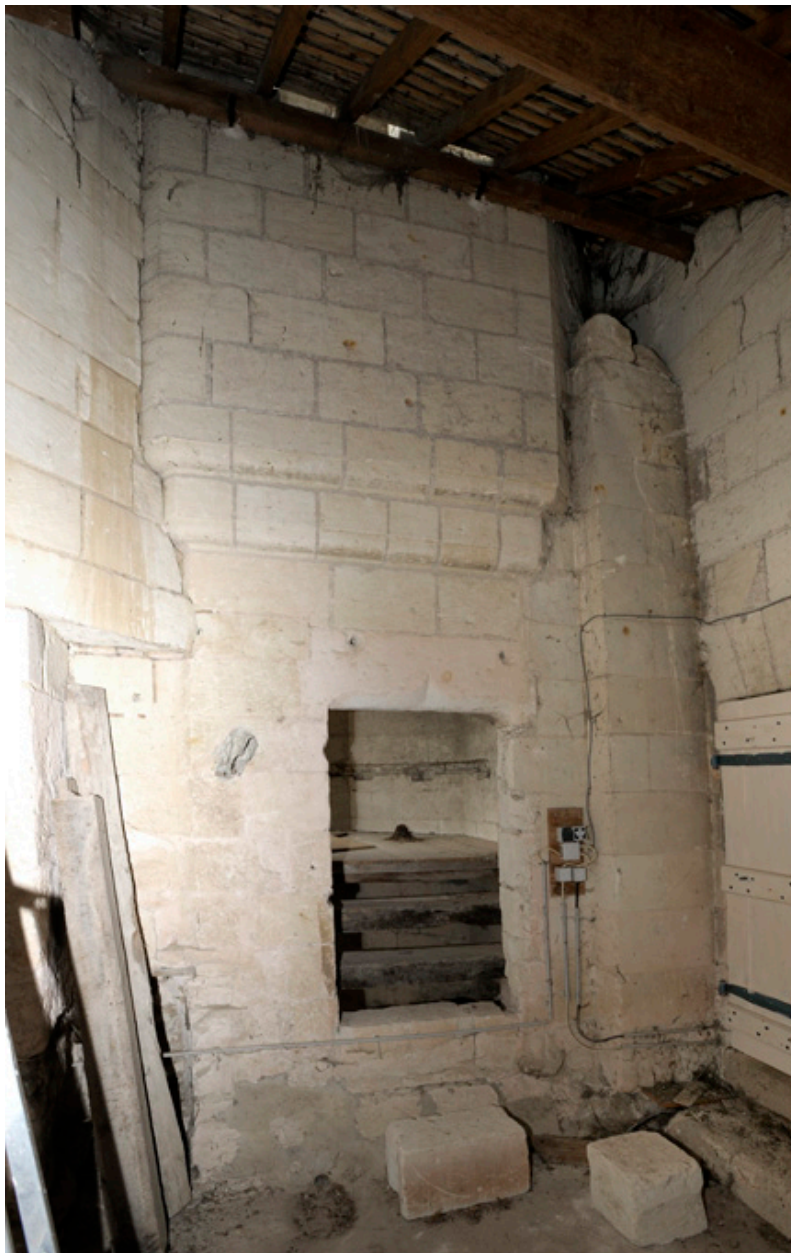
Tourelle d'escalier. Porte d'accès haut depuis l'ancienne terrasse de la basse-cour (aujourd'hui partie couverte par un flanquement en appentis), avec encadrement chanfreiné et linteau à accolade.
