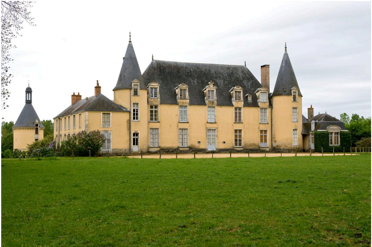
Elevation postérieure du logis.
