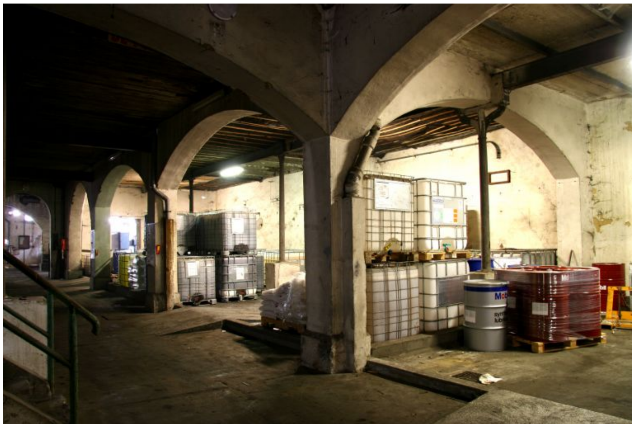
Bâtiment de stockage parallèle à la salle des machines 1 et 2.
