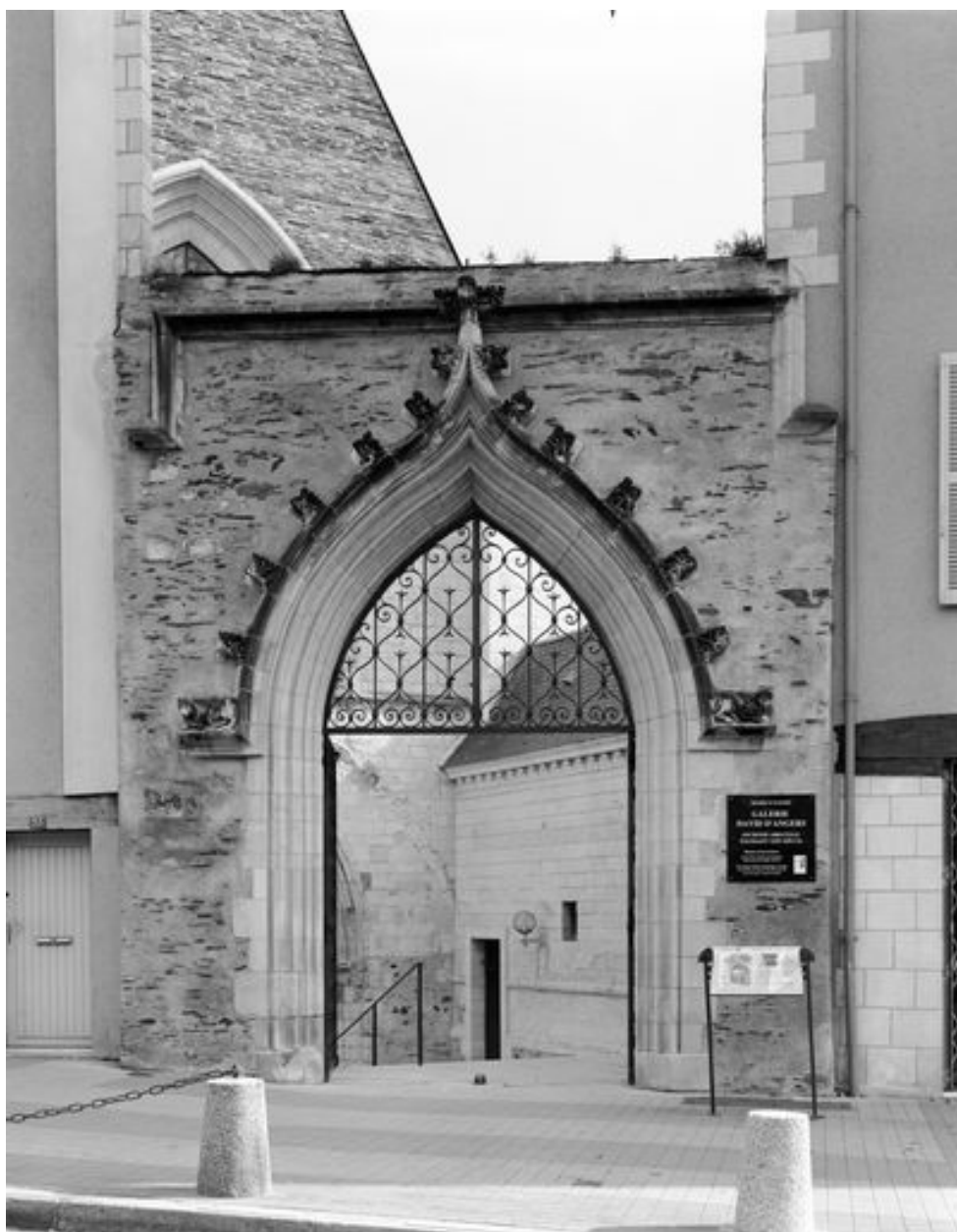
Portail d'accès à la cour de l'abbatiale : élévation sur rue, vue d'ensemble.
