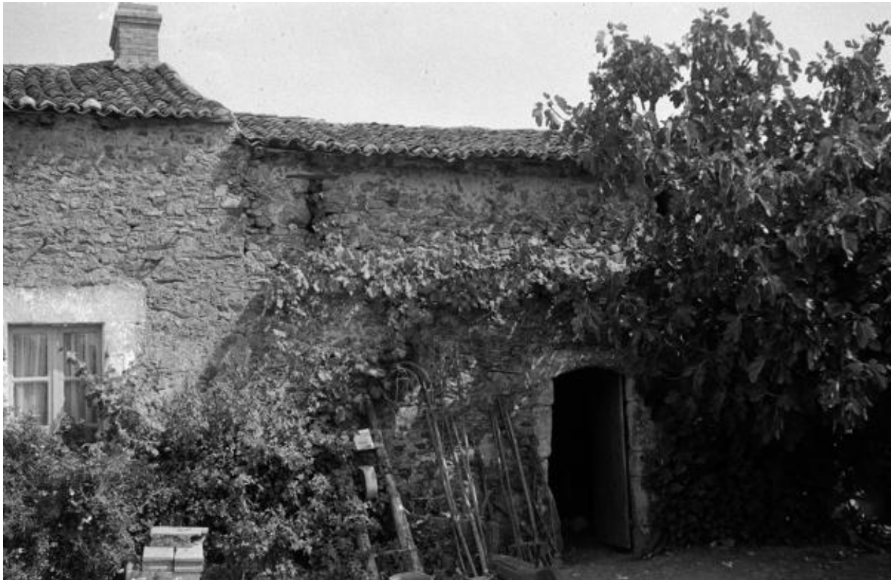
La Jolivetière. Ferme n° 1. Vue de la chambre sud en 1972.
