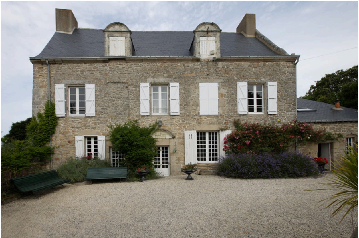
Logis. Vue de la façade antérieure.
