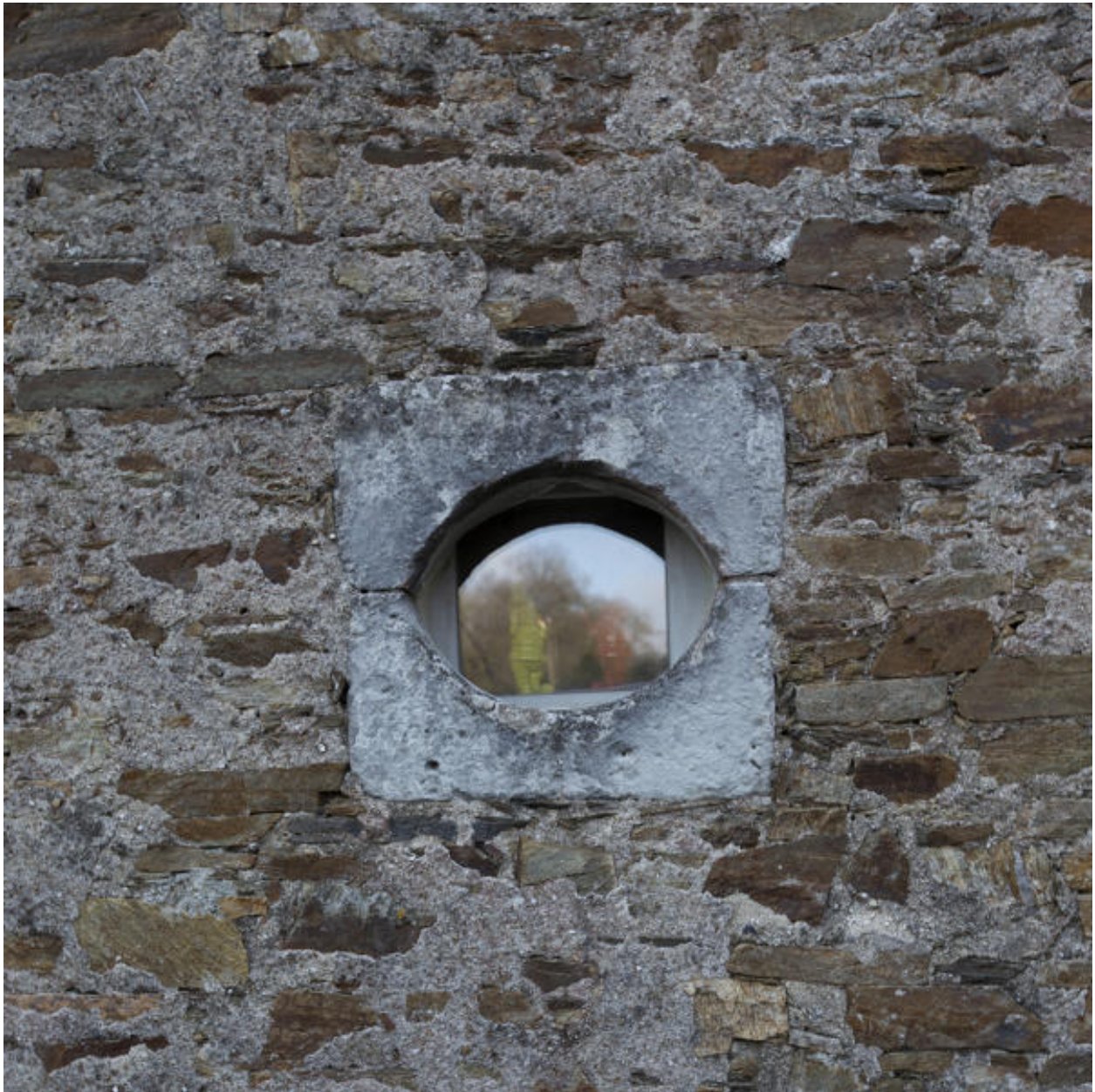
Maison, 3 rue du Port Navalo. Détail d'une ouverture.
