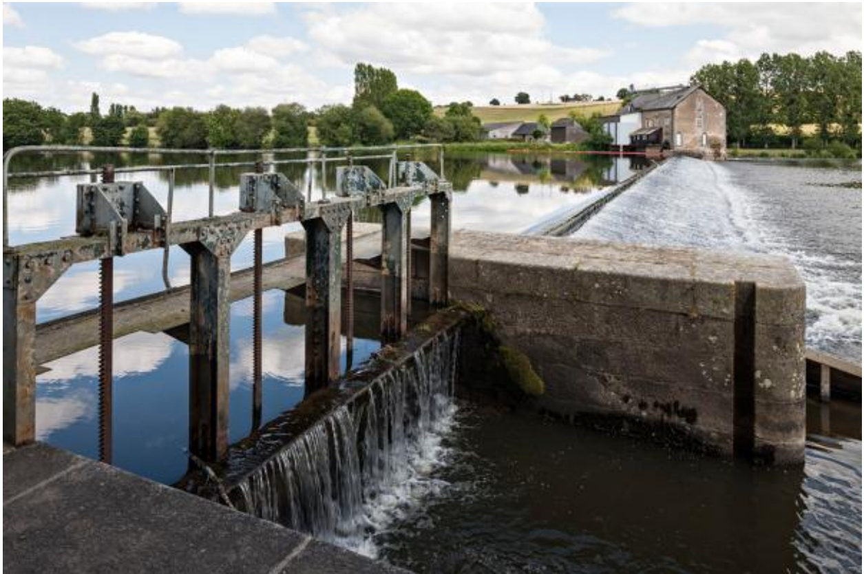
Le pertuis, le barrage et le moulin de la Grande-Bavouze vus depuis le moulin de la Petite-Bavouze, à l'ouest.
