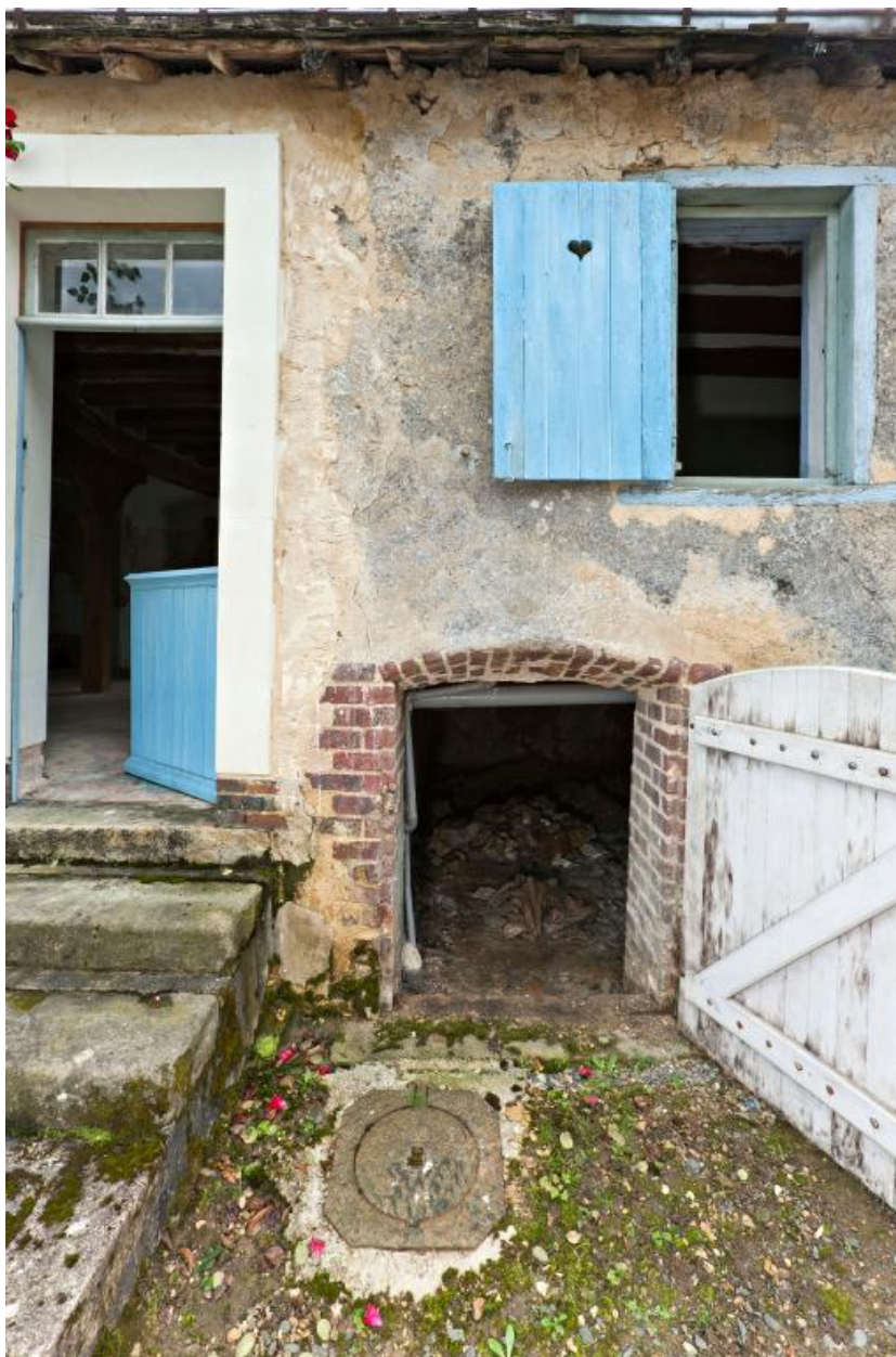
Maison 1, façade sur rue : cave semi-enterrée.
