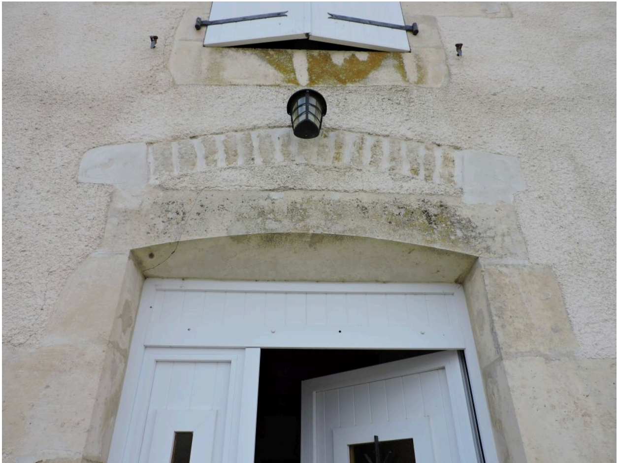
L'arc de décharge au-dessus de la porte.
