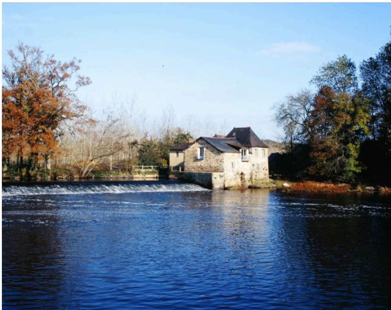
Vue de trois-quart depuis la rive droite en aval : façades ouest et sud du moulin.
