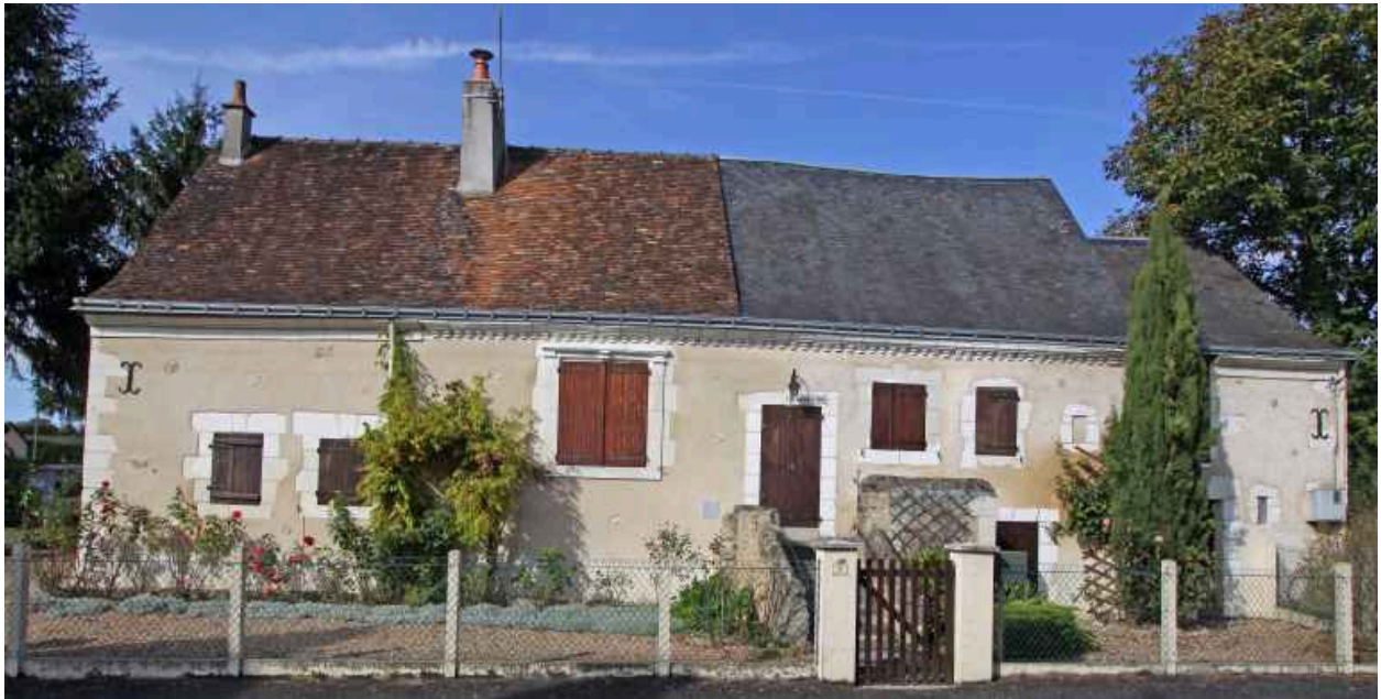
Façade antérieure sur rue.
