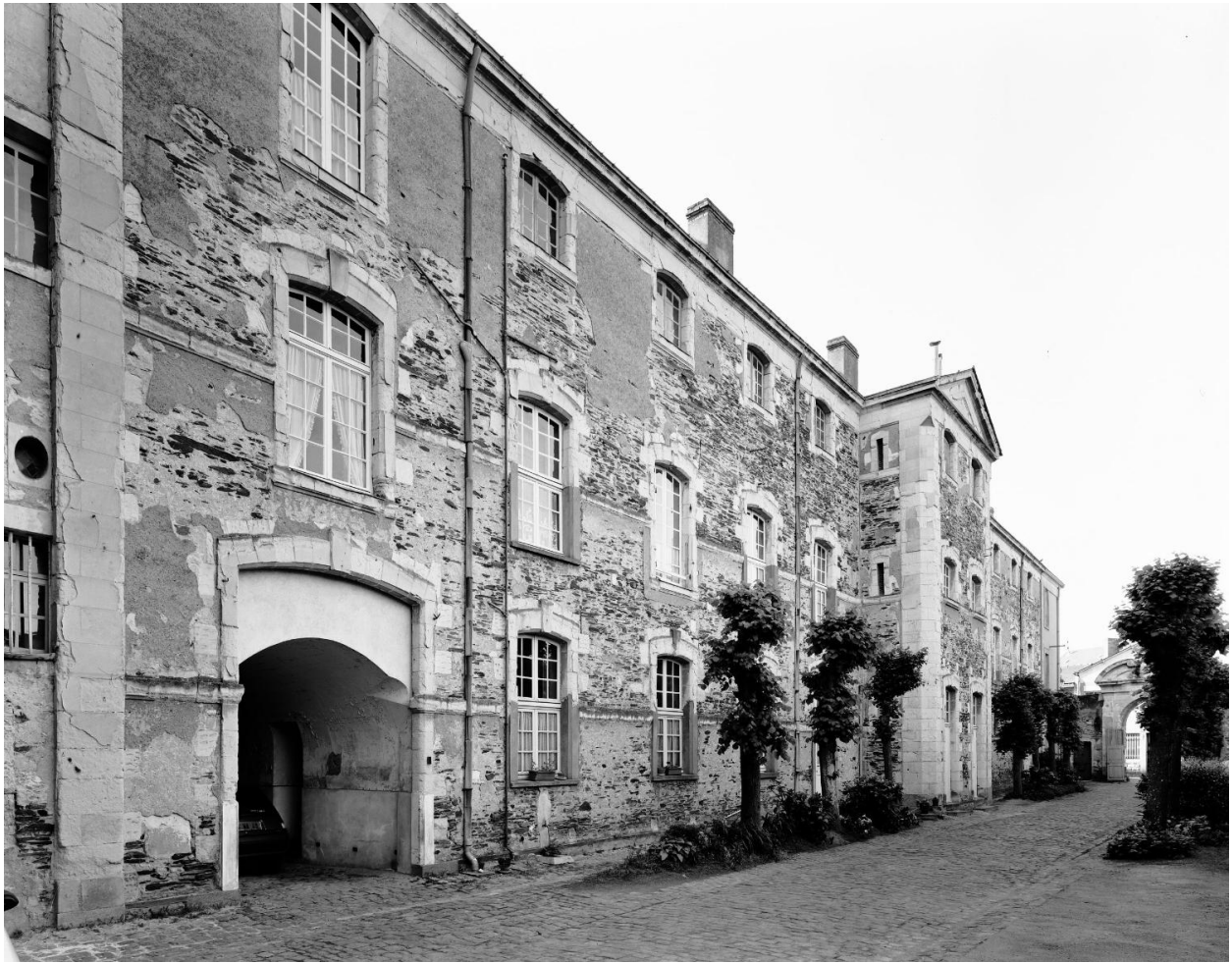
Porterie et pensionnat : façade ouest, sur la cour d'entrée.
