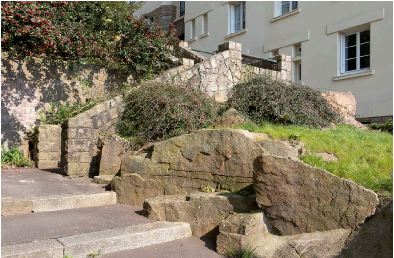
Escalier situé entre les bâtiments D et E.
