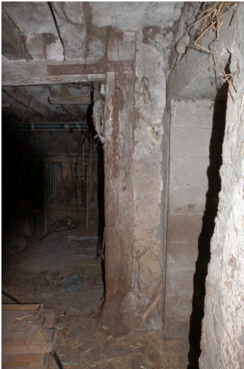
Grange étable : structure en bois et torchis.
