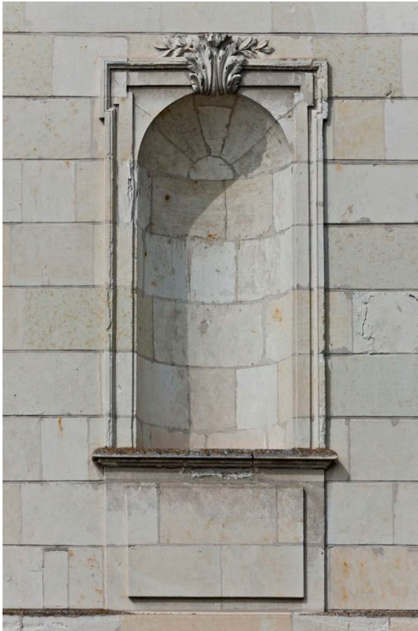
Aile est, avant-corps central, détail : niche à droite.
