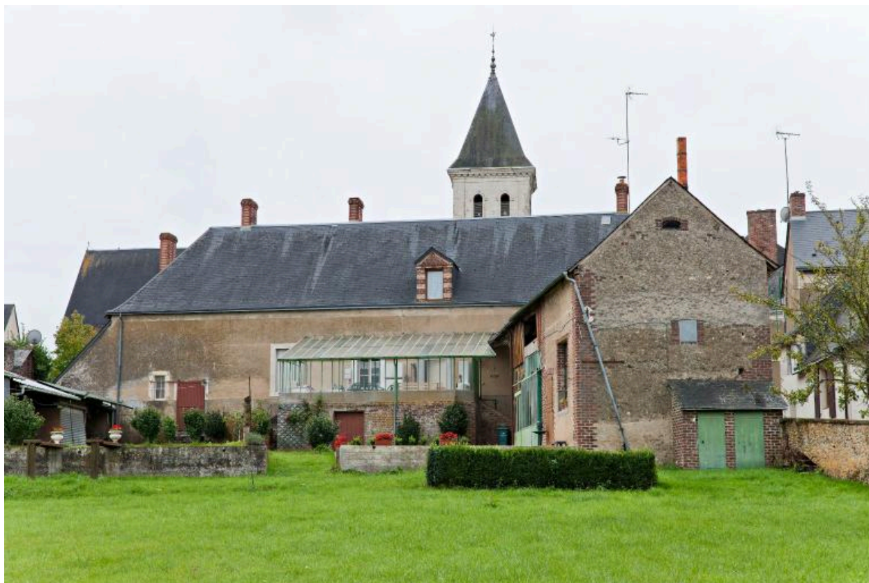
Vue d'ensemble prise depuis le nord.
