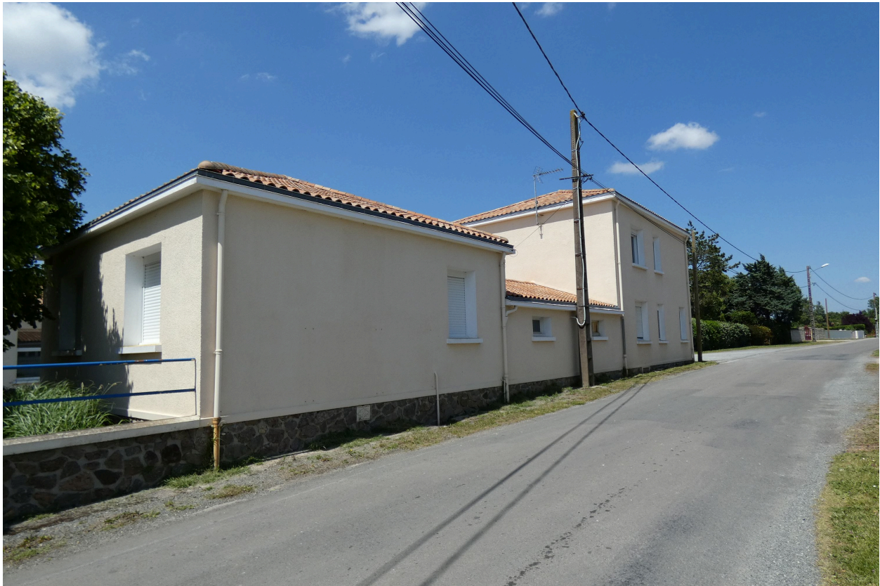
Les anciens logements de fonction, à l'est de l'ensemble, vus depuis le sud.
