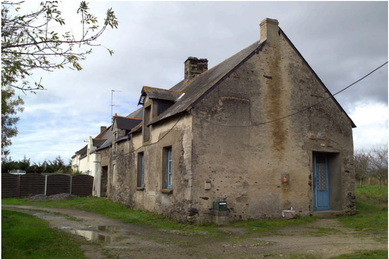
Ensemble depuis le nord-est, élévations antérieure et droite.
