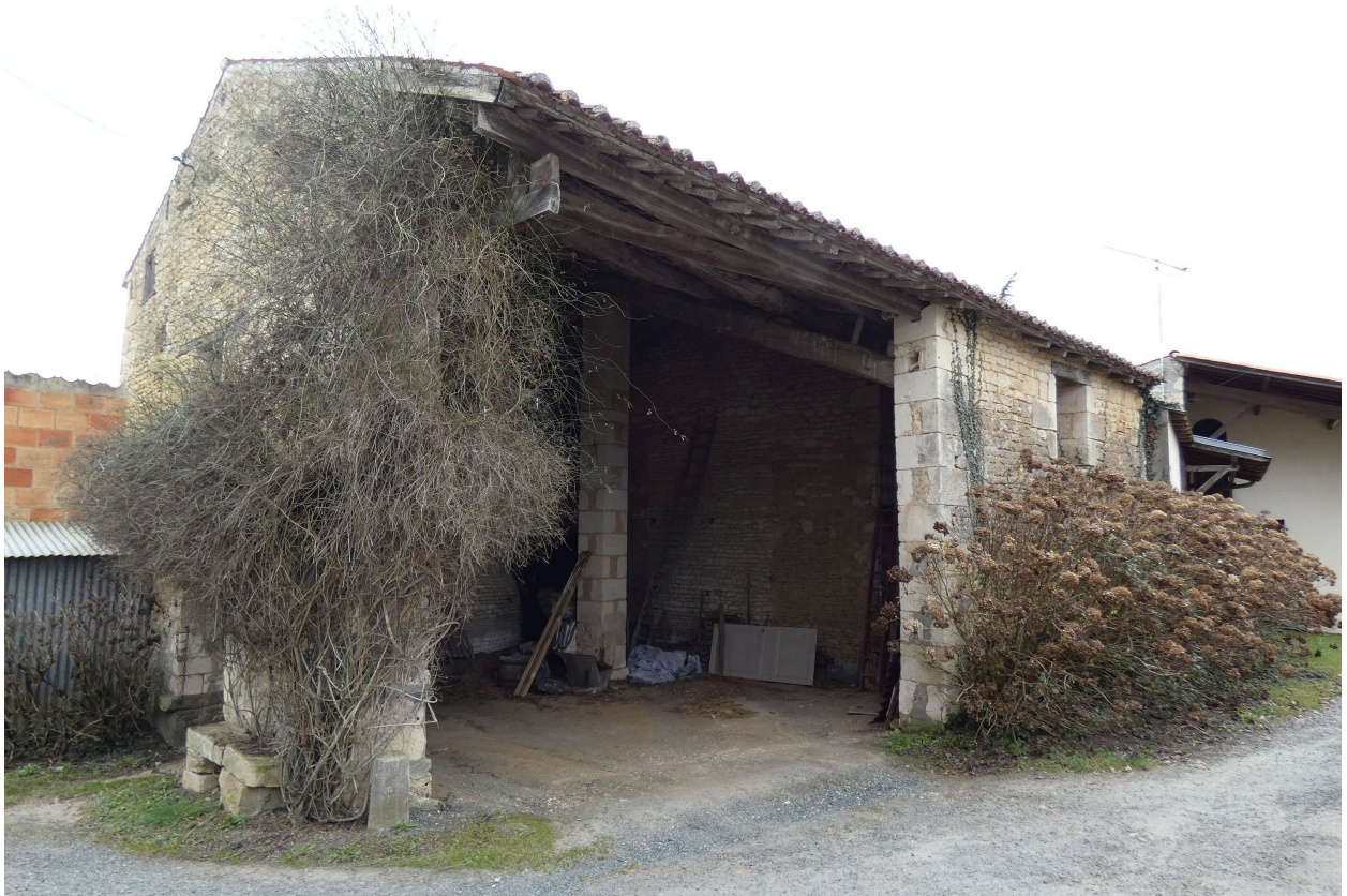
Le hangar en pierre, au sud-ouest de l'ensemble, vu depuis le nord-est.
