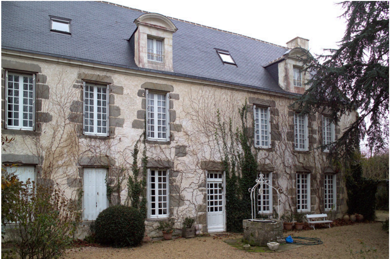
Vue de la façade sud ; portion orientale.
