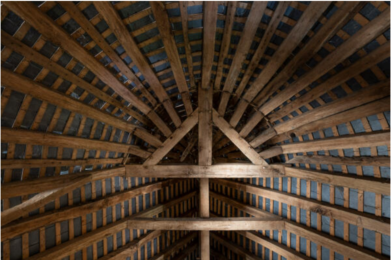
La charpente du bâtiment en abside.
