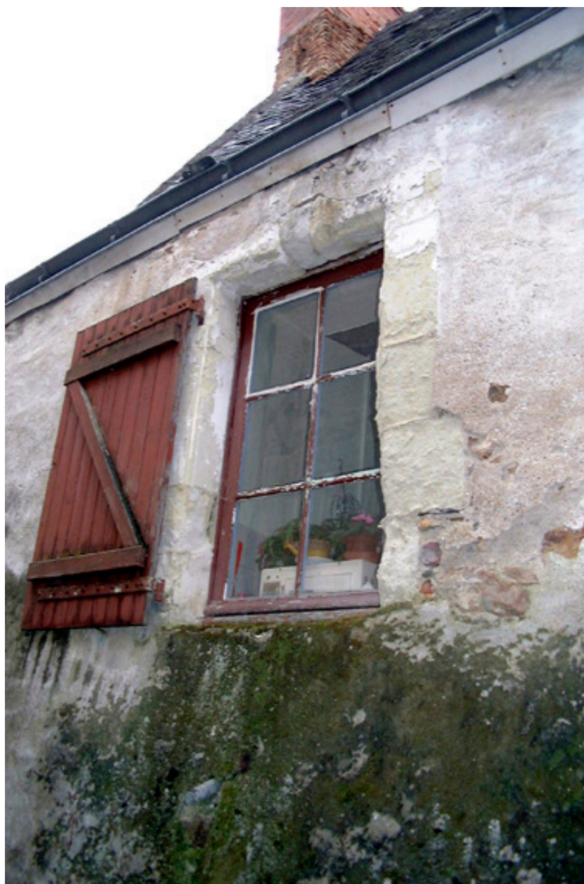
Détail d'une croisée sur le mur goutterau nord.
