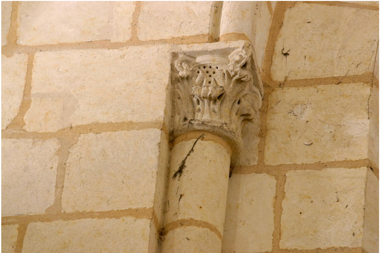
Chapelle Saint-Eloi. Deuxième travée : baie nord, chapiteau de la colonnette ouest (gauche).
