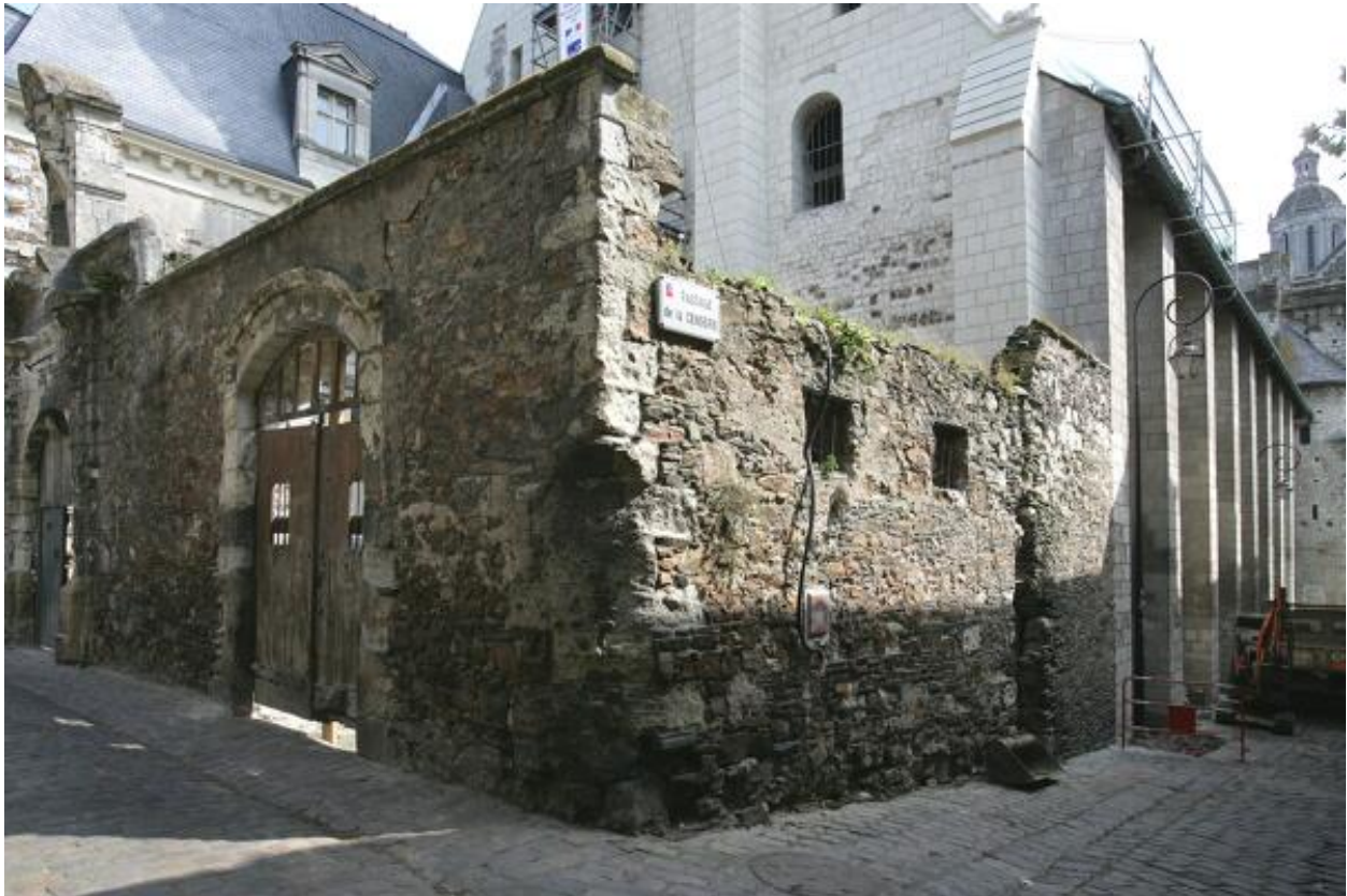
Vue d'ensemble du mur d'enclos bordant la cour d'entrée de l'abbatiale, à l'angle des rues et passage de la Censerie.
