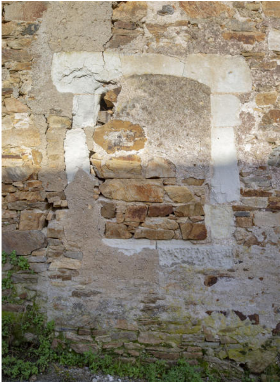
Maison, 24 rue de la Paix. Détail d'une ouverture de la façade sur rue.
