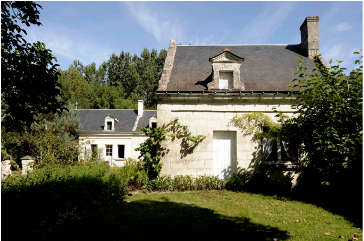
Façade principale de la maison du XVIIIe siècle.
