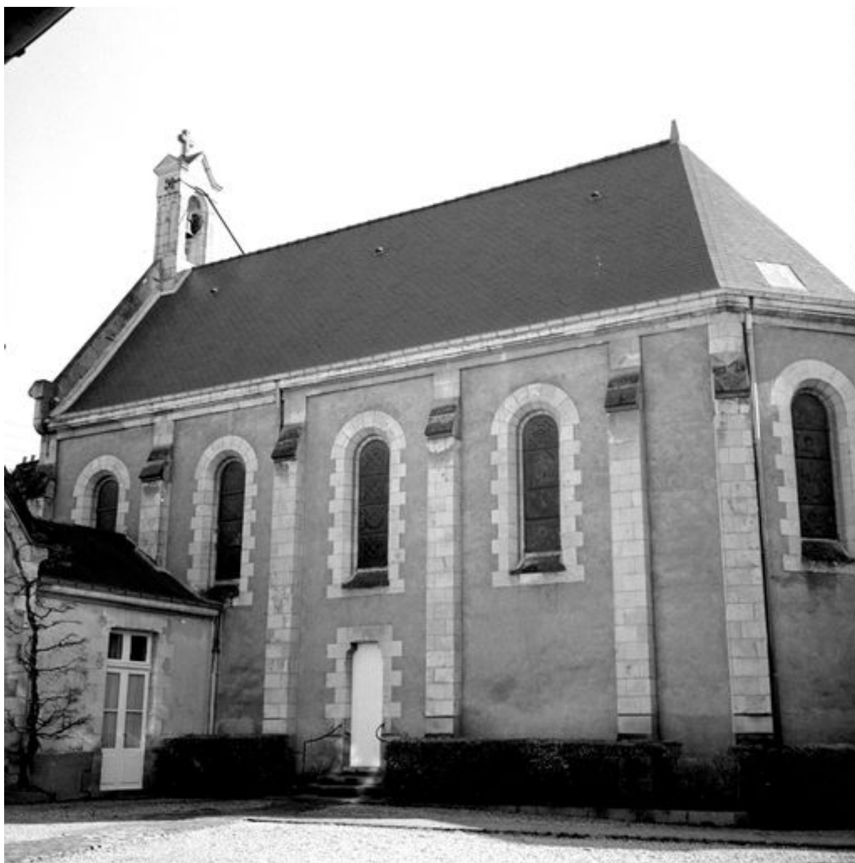
Elévation nord de la chapelle
