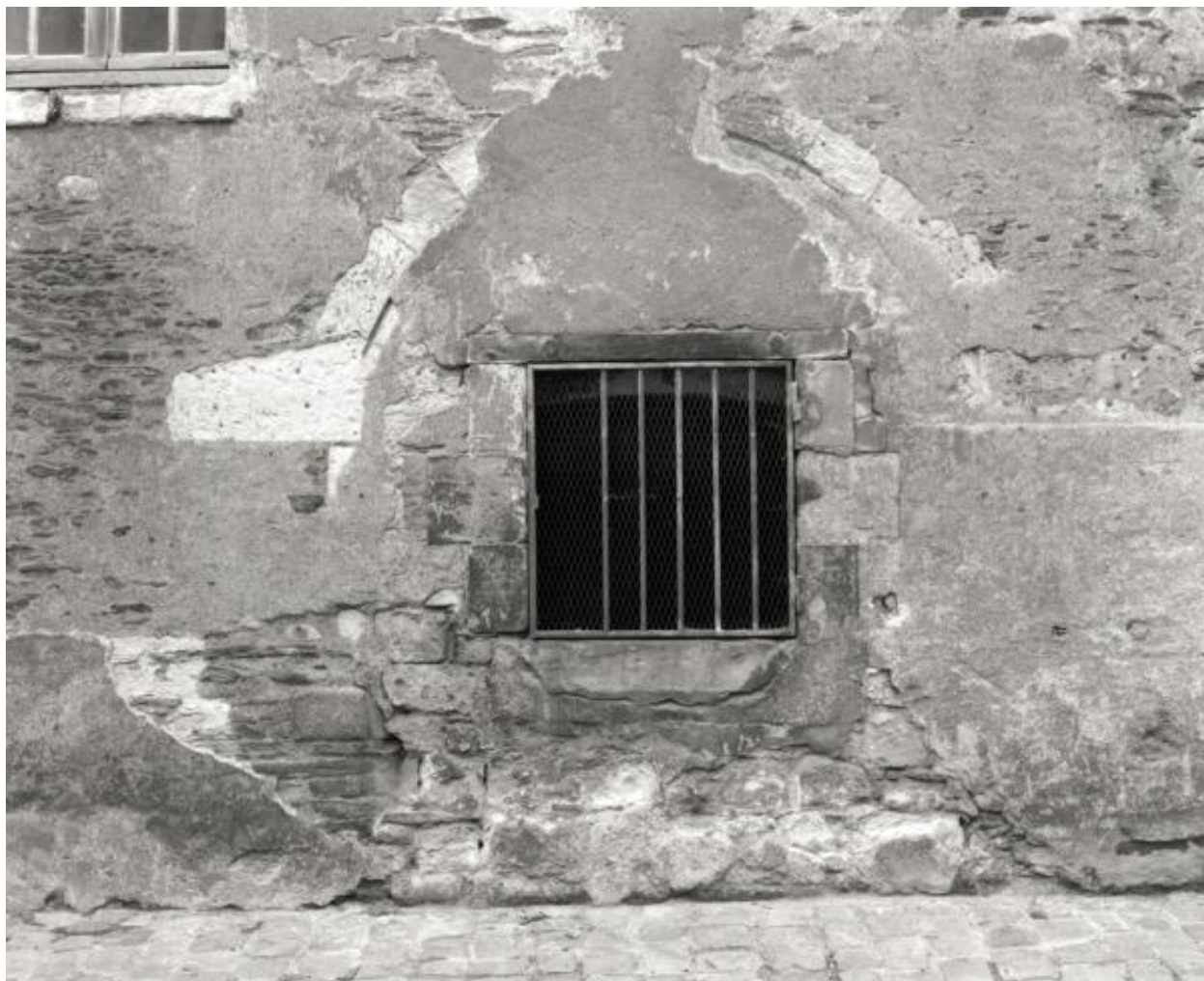
Aile ouest du cloître : élévation ouest, sur la rue de la Censerie : porte du XVe siècle, murée (au sud de la courette de service).
