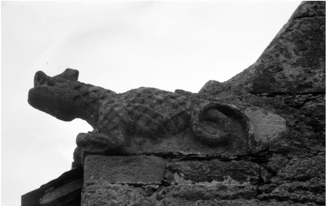
Détail d'une crossette zoomorphe dans l'angle nord-est du logis.
