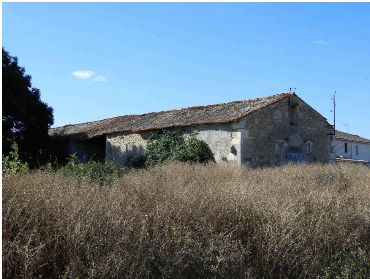
La grange-étable vue depuis le nord-est.
