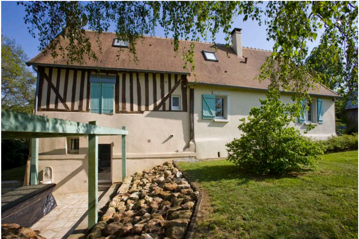
Elévation postérieure du logis.
