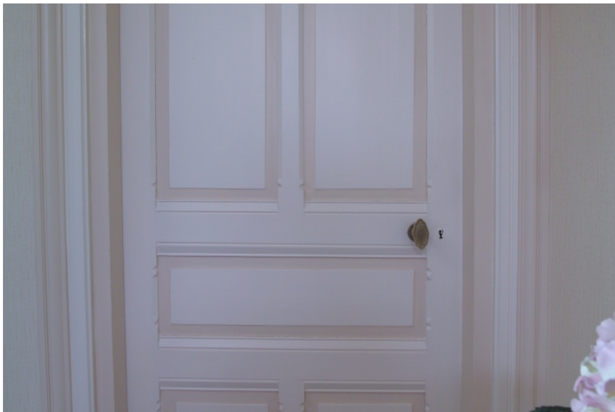
Détail d'une porte du rez-de-chaussée.
