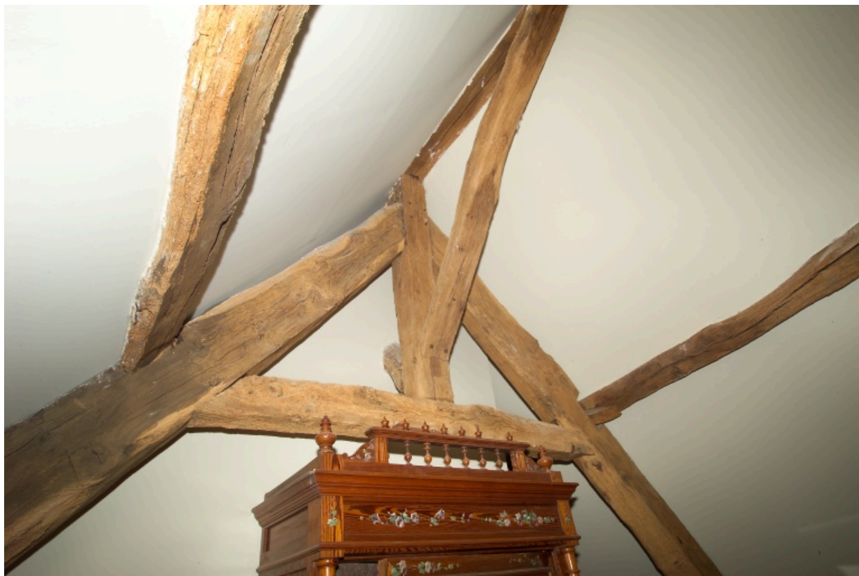
Corps sud, charpente.
