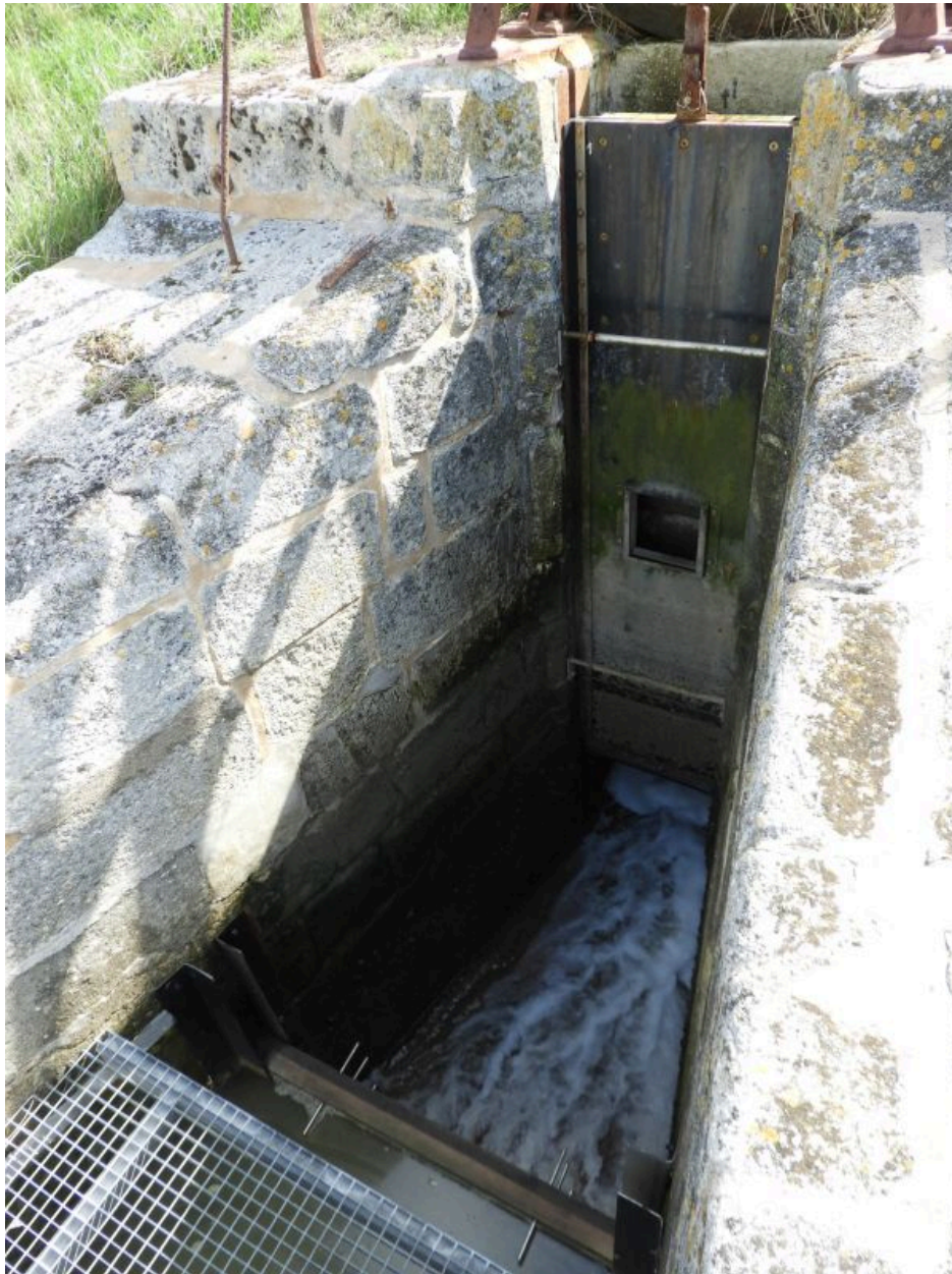
Détail de la porte côté amont : barrage à poutrelles et vanne verticale.
